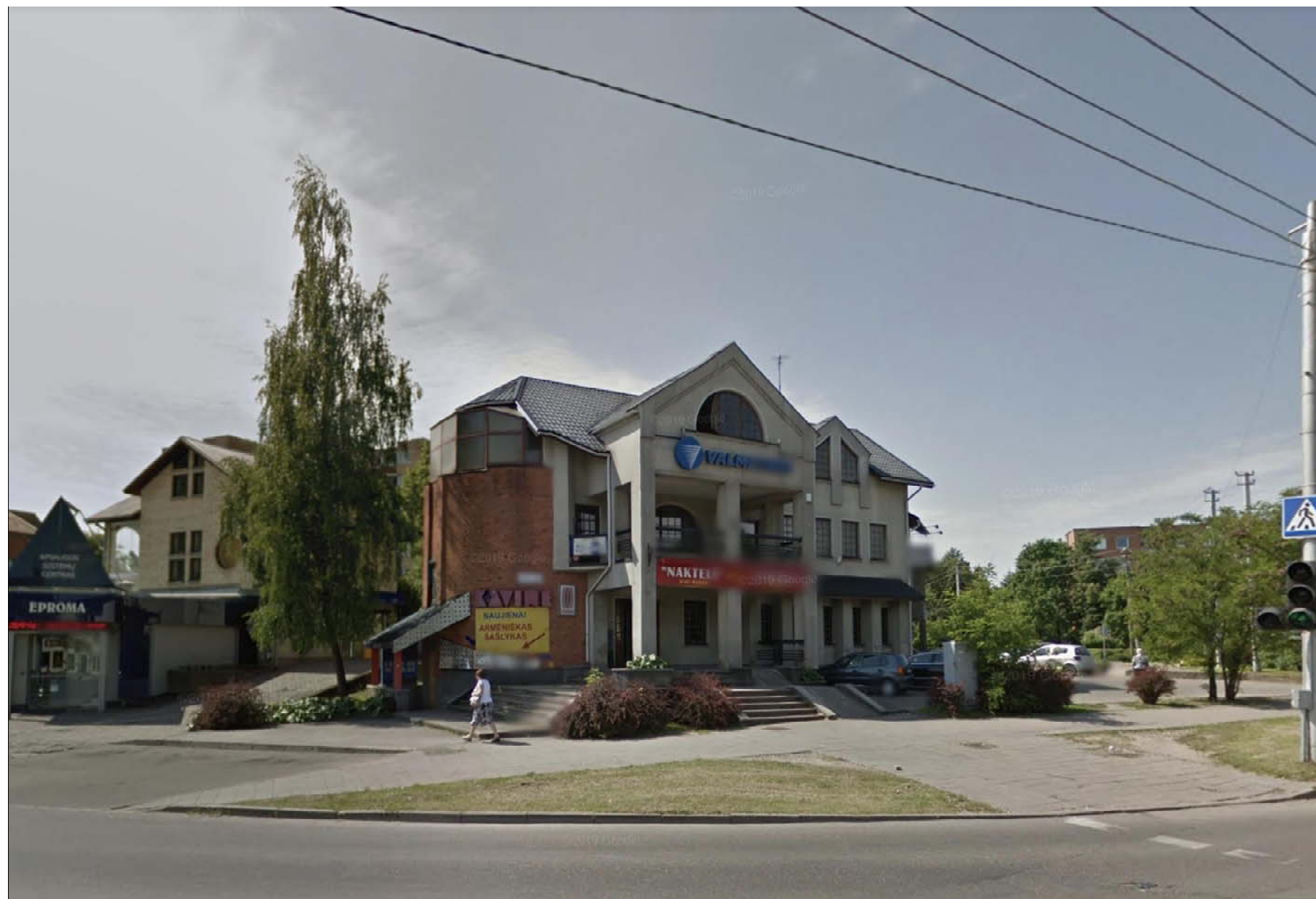
ŠIAURĖS VAKARŲ FASADAS
